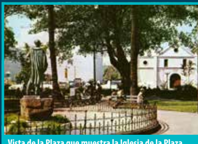
Vista de la Plaza que muestra la Iglesia de la Plaza Vieja, c. 1950
