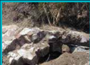
Desenterrando a la Madre Zanja
